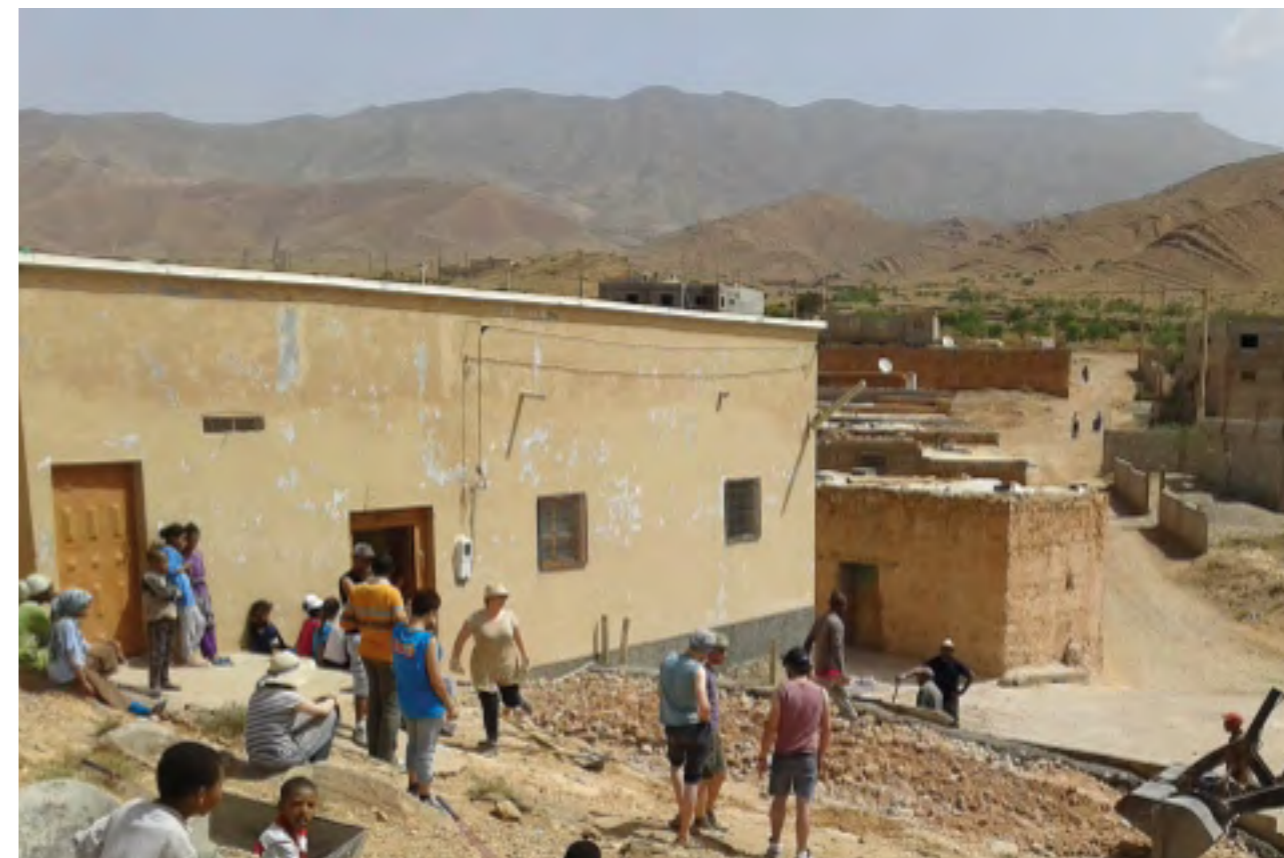
— Chantier d'aménagement dans le village de Timilit, projet « Fil Rouge Maroc » - 3, avec Groupe d'Appui et de Solidarité, juin 2015 ©Migrations & Développement
